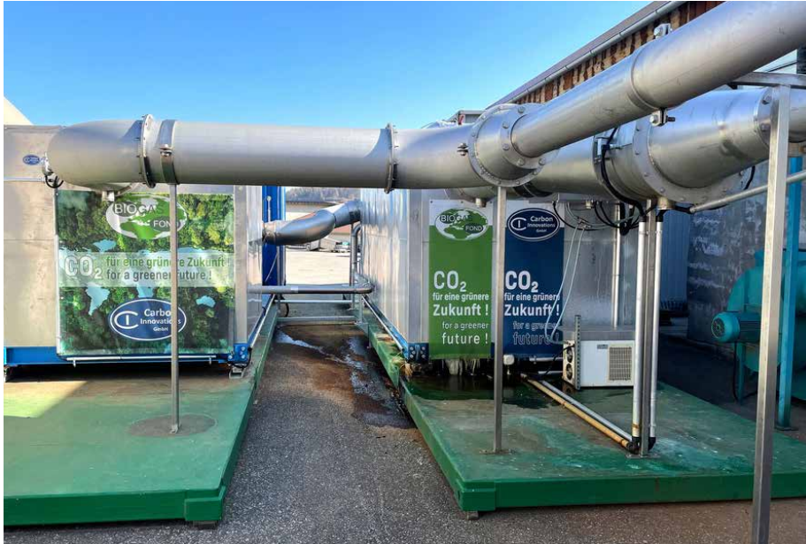
Geschäftsführer von Bree geht davon aus, dass er bei einer 1-MWel-Biogasanlage mit der Abgasreinigungsanlage 7.000 t CO 2 pro Jahr einsparen kann.
